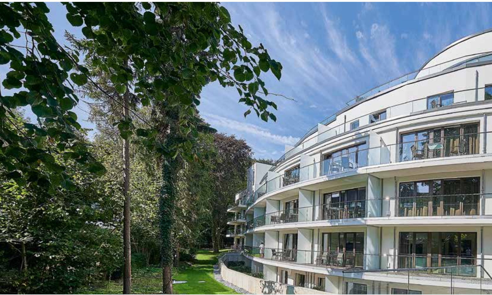
„White Pearl” Apartmanház, a timmendorfi strandon Hörmann termékekkel
