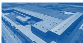
Hörmann Tianjin, Kína
